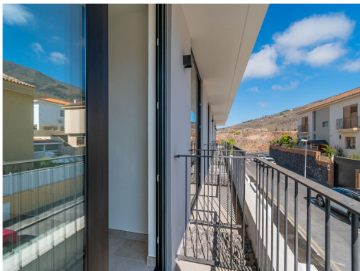
Balkon auf der 1. Etage
