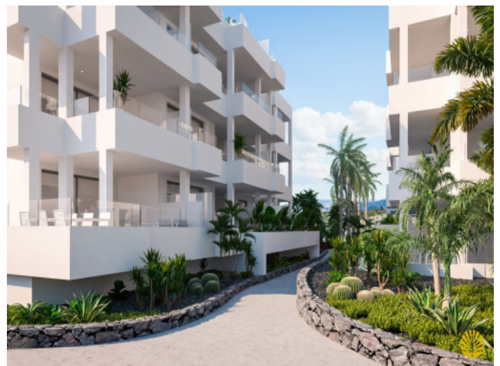
Zugang zum Gebäude
